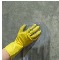
Opvullen bij middel van een kegelvormige plug met Sika®-4a, daarna bekleden met een Super Sikalite® bepleistering.
