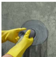
Een opvang-buis in de opening zetten en vastzetten met Sika®-4a.
