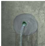
De waterdichting afwerken en de buis verwijderen.
